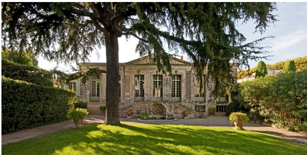
Façade de la rue de la Merci
