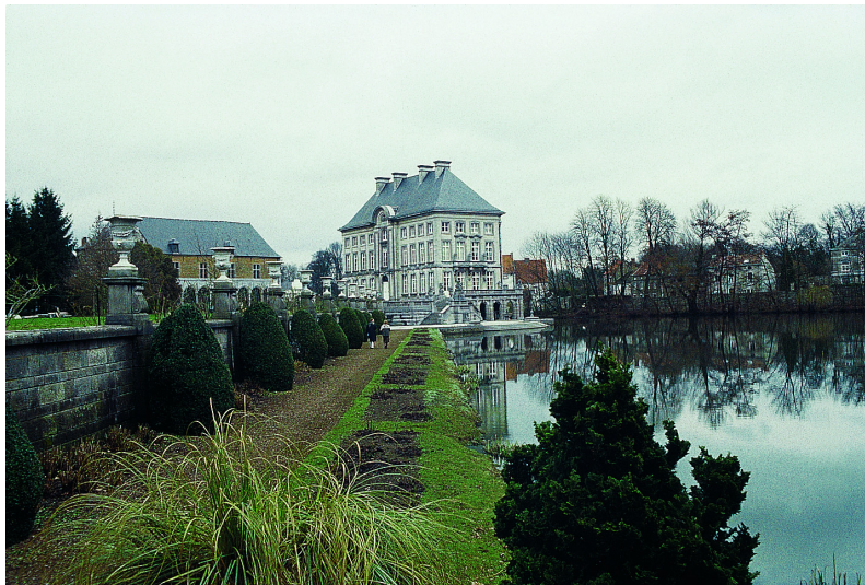
D'importants ouvrages de soutènement retiennent les terrasses jardinées installées en contre-haut des anciennes douves élargies en plans d'eau décoratifs. L'imposant ensemble entamé en 1940 n'a jamais été terminé. © N. de Harlez
