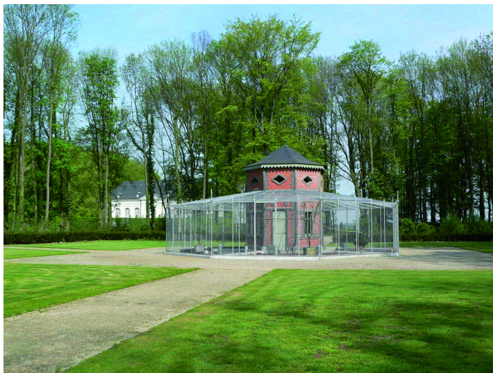
La volière reconstruite à son emplacement. © N. de Harlez
