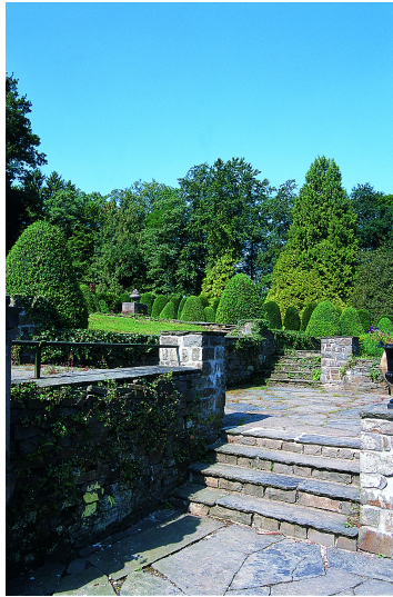
Les soutènements en schiste des terrasses sont interrompus sur une suite de courtes volées d'escaliers alternant avec des repos. © Inventaire des parcs et jardins historiques de Wallonie
