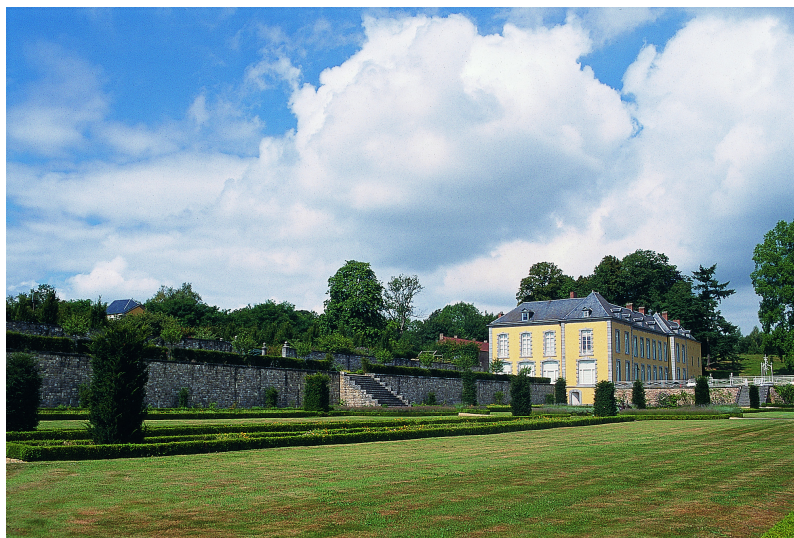
Grande terrasse médiane replantée et murs de soutènement restaurés des terrasses supérieures. © N. de Harlez
