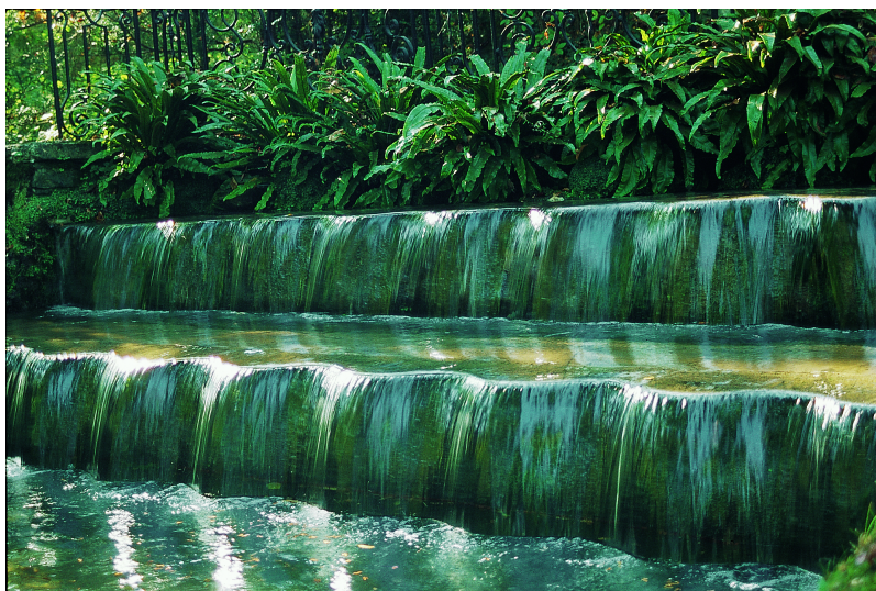
Au sortir de la grotte des Nains, les nappes d'eau approvisionnent la tête du petit canal. L'esthétique de ces chutes d'eau au profil festonné visait à imiter les barrages de travertin naturellement présents dans la vallée voisine du Hoyoux exploitée jadis par des ateliers hydrauliques. © J. Barlet
