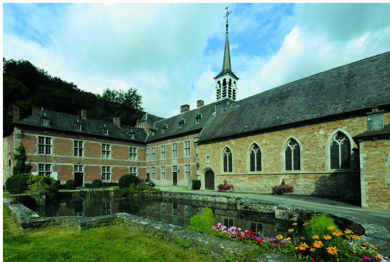
Ancien vivier au centre de la cour d'honneur. Cliché G. Focant © Service Public de Wallonie (SWP)
