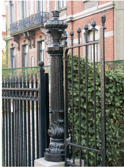
De rijk uitgewerkte gietijzeren zuil van het voortuinhek aan de Guffenslaan nummer 29. Het poorthekje is in smeedijzer. (Pauwels, Oswald, 01-01-2006, ©Vlaamse Gemeenschap)
