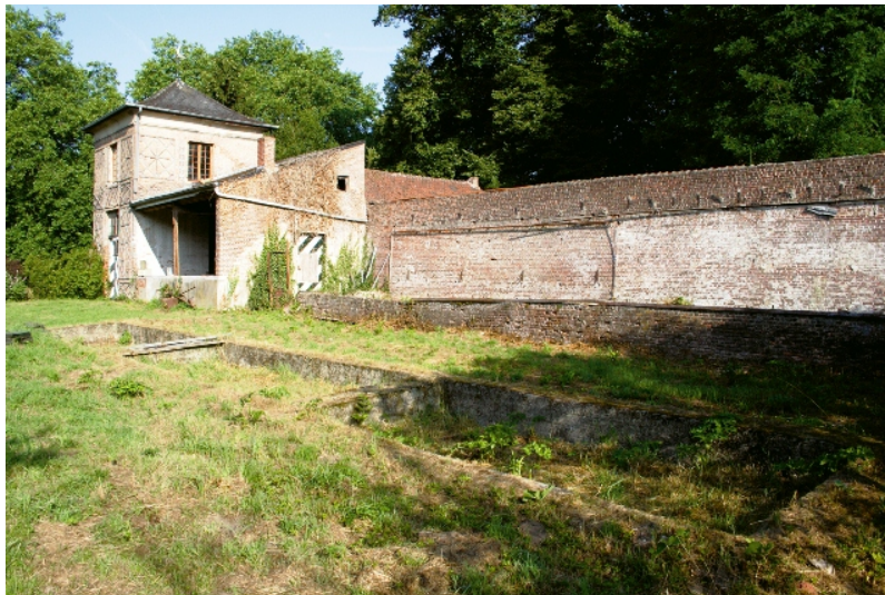
Oranjerie, serres en koude kassen aan de rand van de moestuin bij het kasteel van Schiplaken (Pauwels, Oswald, 20-03-2014, ©Vlaamse Gemeenschap)
