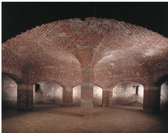
De monumentale onderaardse kelder met graatgewelf uit 1836 in het voormalige sterrenbos bij Nieuwermolen (Verhasselt, Miel, 01-01-1997, ©Vlaamse Gemeenschap)
