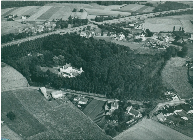
Het kasteeldomein La Motte te Sint-Ulriks-Kapelle in 1974 vanuit het zuidwesten, de autosnelweg E40 op de achtergrond (INBEL, 01-01-1974, ©Vlaamse Gemeenschap)
