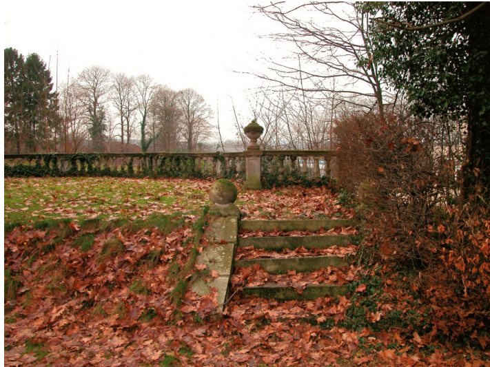
Een van de betonnen trapjes naar en de balustrade van het belvédèreterras (Deneef, Roger, 01-01-2002, ©Vlaamse Gemeenschap)
