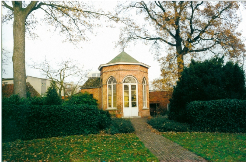
Achthoekig tuinpaviljoen bij villa Paula aan de stadsrand van Aarschot (Deneef, Roger, 20-03-2014, ©Vlaamse Gemeenschap)
