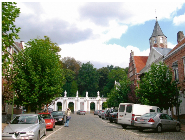
Herenhuis Verstappen in 1945 omgebouwd tot monumentale toegang van het stadspark te Diest, bekroond met beelden van het in 1956 afgebroken noordstation (Deneef, Roger, 24-09-2003, ©Vlaamse Gemeenschap)
