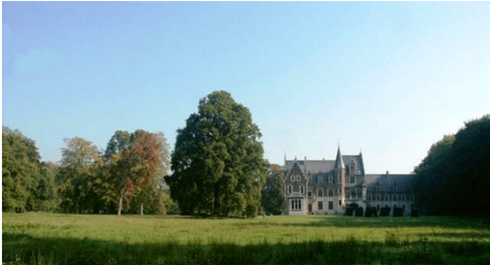
De achtergevel van het kasteel vanuit het park (Deneef, Roger, 19-09-2003, ©Vlaamse Gemeenschap)
