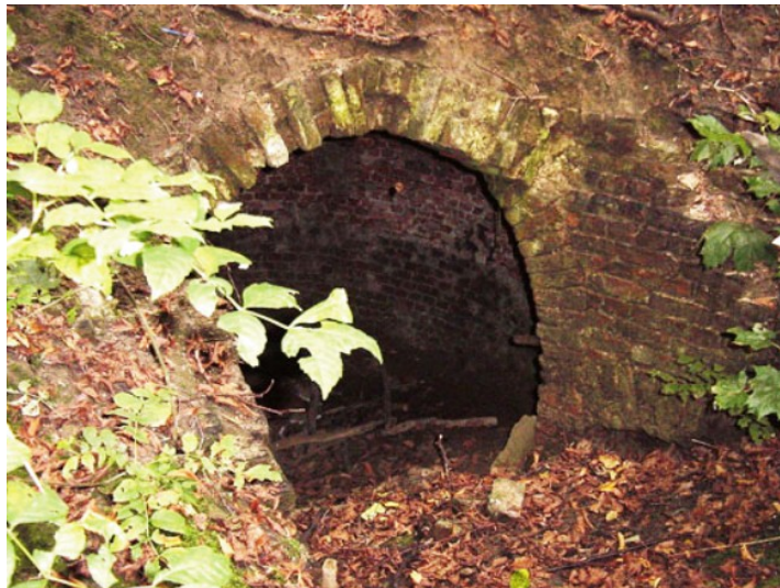
In de schaduw van het viaduct de ijskelder van Drie Fonteinen (Deneef, Roger, 03-10-2002, ©Vlaamse Gemeenschap)
