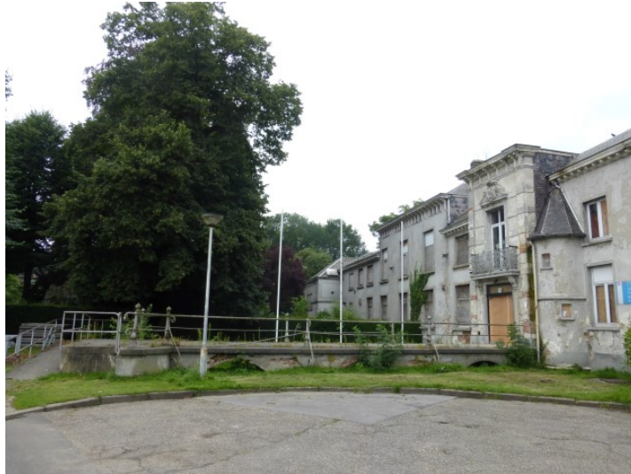
Antwerpen Terlindenhofstraat 204 Toegangsbrug van het landhuis Runcvoort. (Michiels, Marijke, 12-08-2016, ©Vlaamse Gemeenschap)
