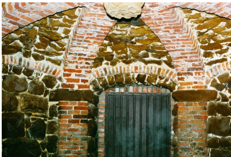
Het koepelgewelf met hergebruikte gewelfsleutel in het tuinpaviljoen in het voormalige abdijdomein Vrouwenpark (Paesmans, Greta, 20-03-2014, ©Vlaamse Gemeenschap)
