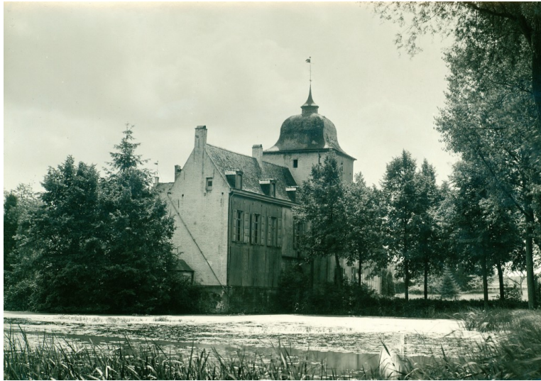
Het witgepleisterde Kasteel Nieuwermolen vanuit het noordwesten in 1914, voor de restauratie door Paul Saintenoy in 1928-1932 (Agentschap Onroerend Erfgoed, 01-01-1914, ©Vlaamse Gemeenschap)
