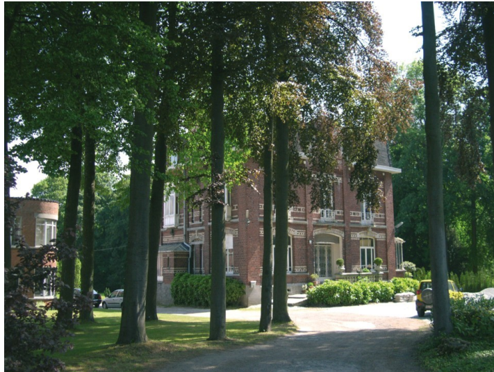
De door Legros gebouwde villa verloor aan het einde van de jaren 1950 veel van zijn pittoreske details; links in beeld, de verffabriek van Houben (Deneef, Roger, 27-05-2004, ©Vlaamse Gemeenschap)
