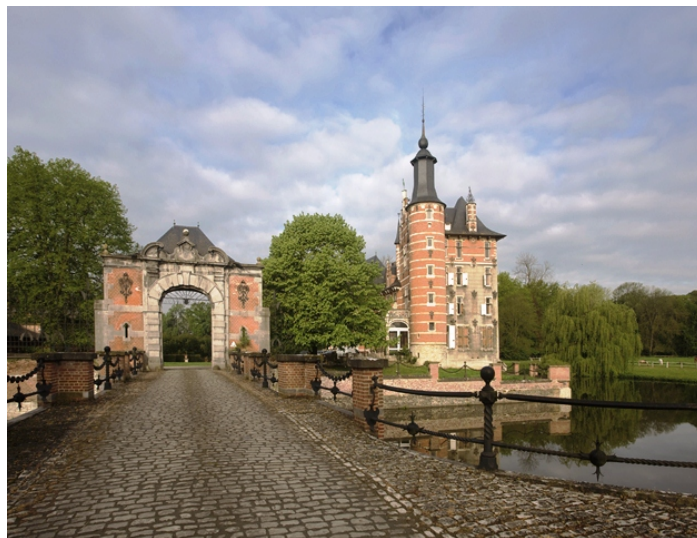
De brug en het poortgebouw bij het Gravenkasteel (Pauwels, Oswald, 12-05-2010, ©Vlaamse Gemeenschap)
