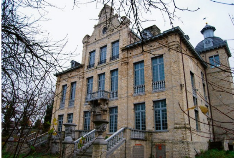
Het kasteel Beaulieu na de recente restauratie (Deneef, Roger, 17-02-2009, ©Vlaamse Gemeenschap)
