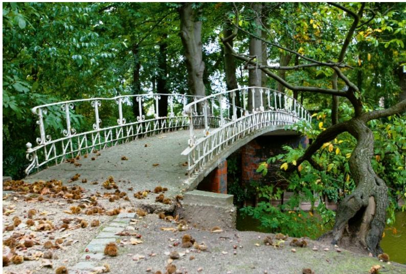
Smeed- en gietijzeren boogbrug nu met een betonnen vloer, in Het Heiken te Haacht (Vandevorst, Kris, 10-10-2003, ©Vlaamse Gemeenschap)
