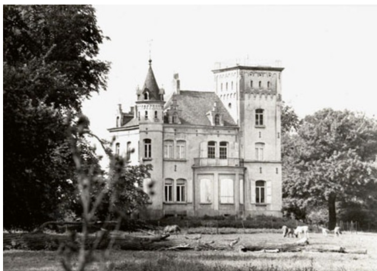
Het pittoreske neomiddeleeuwse 'Château de Huyenhoven' naar ontwerp van Antoine Trappeniers, voor de verbouwing, in een verwaarloosd park (Deneef, Roger, 17-02-2009, ©Vlaamse Gemeenschap)
