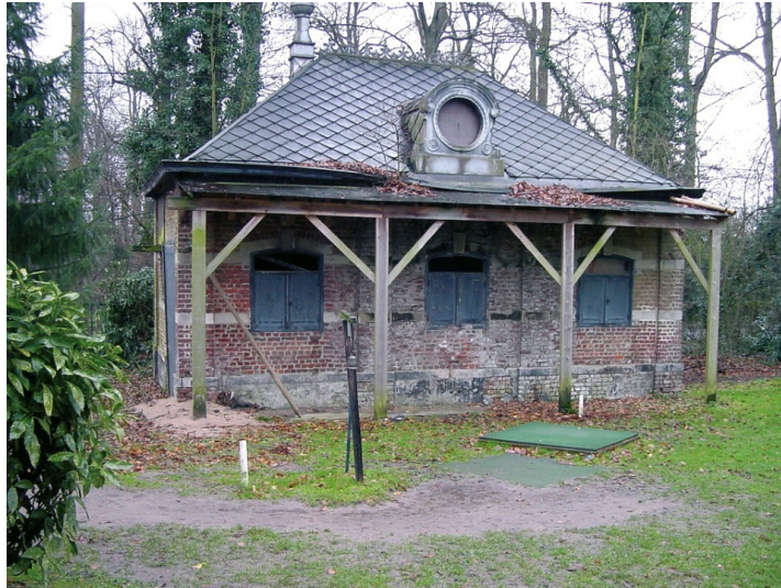
Een rond 1874 opgetrokken gebouwtje dat oorspronkelijk een 'gazometer' huisvestte (Wijnant, Jo, 08-01-2004, ©Vlaamse Gemeenschap)
