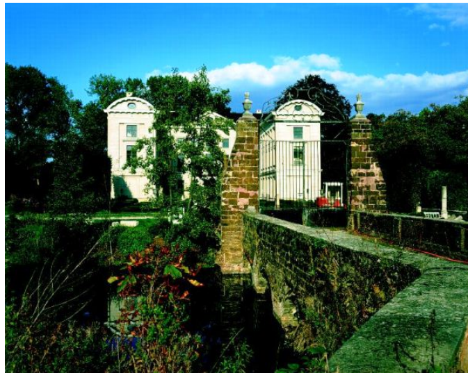
18de-eeuwse brug over de slotgracht bij het kasteel van Schoonhoven (Vandevorst, Kris, 01-01-2003, ©Vlaamse Gemeenschap)
