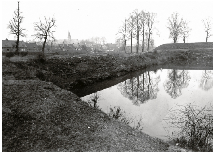
De Diestse vestingwal met op de achtergrond het begijnhof, vlak na de Tweede Wereldoorlog en voor de aanleg van de ringweg. Restanten van oude beplantingen, vooral beuken, aan de voet van de hoofdwal. (Agentschap Onroerend Erfgoed, 20-03-2014, ©Vlaamse Gemeenschap)
