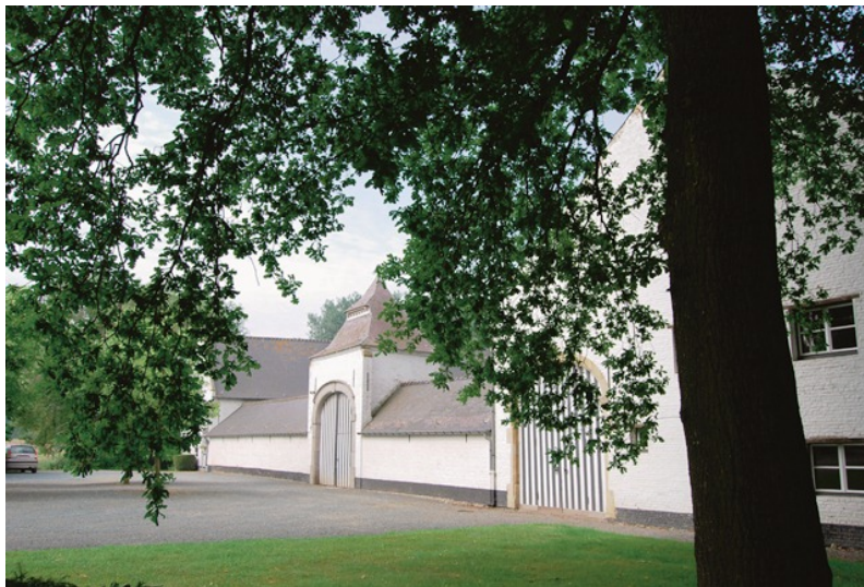
Het neerhof van Kasteel van Impde met de 1673 gedateerde poort- en duiventoren (Deneef, Roger, 02-06-2008, ©Vlaamse Gemeenschap)
