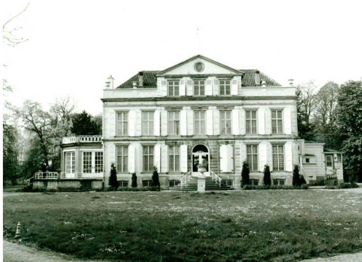
De neoclassicistische voorgevel van het kasteel Ter Wilder in de jaren 1960 (Agentschap Onroerend Erfgoed, 01-01-1971, ©Vlaamse Gemeenschap)
