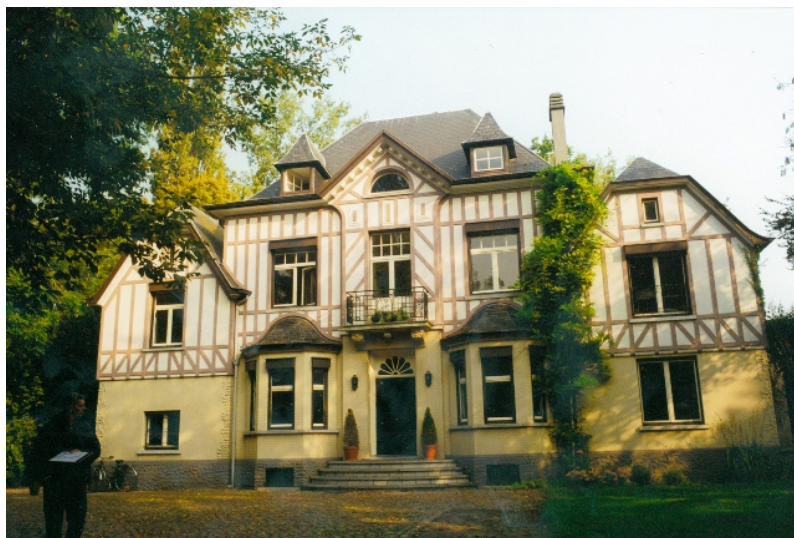
Het Hof Ter Hulst verbouwd tot cottage tijdens het interbellum (Deneef, Roger, 20-03-2014, ©Vlaamse Gemeenschap)
