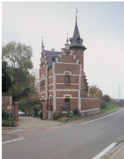
De rond 1890 gebouwde portiersloge van het kasteel Inkendaal aan de Postweg (Vandevorst, Kris, 01-01-2004, ©Vlaamse Gemeenschap)
