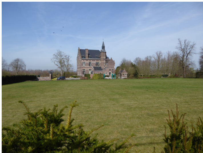
Linter Melkwezerstraat 73 (Vynckier, Geert, 26-03-2017, ©Vlaamse Gemeenschap)
