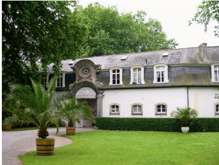
De dienstvleugel met de inrijpoort, door Despret in 1908 opgetrokken vanaf de straat (Deneef, Roger, 24-06-2007, ©Vlaamse Gemeenschap)
