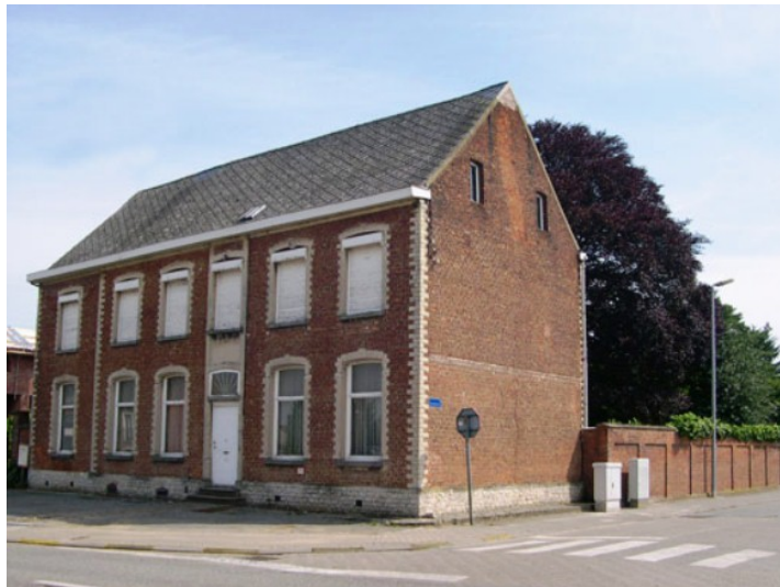
De voormalige pastorie van Elewijt, voor de restauratie van 2008-2009, sinds 1962 zonder voortuin, met een ommuurde, door een bruine beuk overschaduwde achtertuin (Deneef, Roger, 19-06-2007, ©Vlaamse Gemeenschap)
