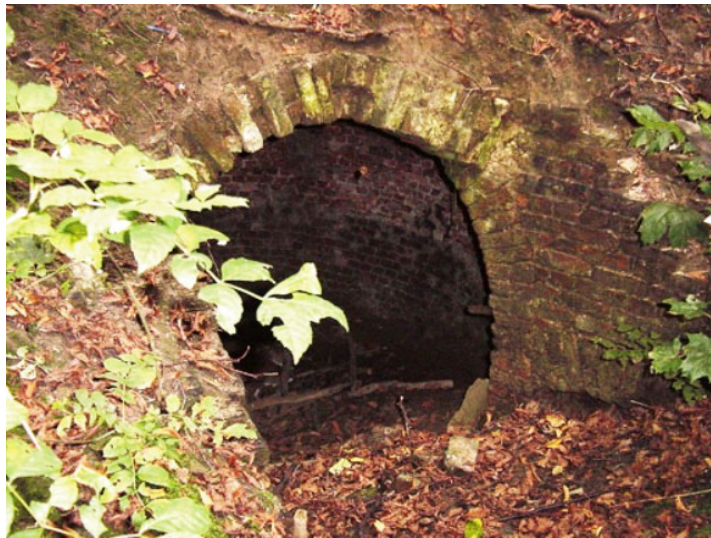
In de schaduw van het viaduct de ijskelder van Drie Fonteinen (Deneef, Roger, 03-10-2002, ©Vlaamse Gemeenschap)
