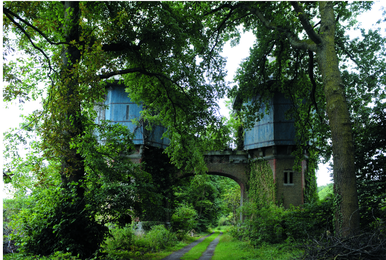
Le double château d'eau est constitué de deux tours jumelées. Cliché G. Focant © Service Public de Wallonie (SWP)
