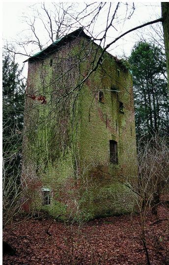
La tour du château d'eau de 1720 cache sous sa toiture un réservoir de plomb destiné à alimenter le bassin des Dauphins tout proche. Désaffectée depuis de longues années, la construction tombe en ruines. © Inventaire des parcs et jardins historiques de Wallonie
