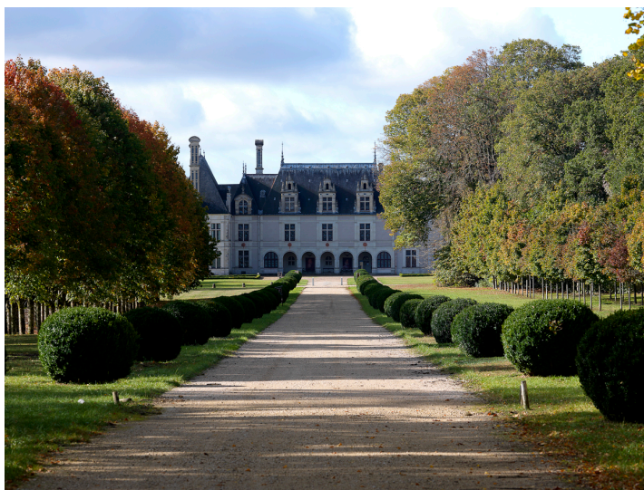
Façade allée Chambord © beauregard-events
