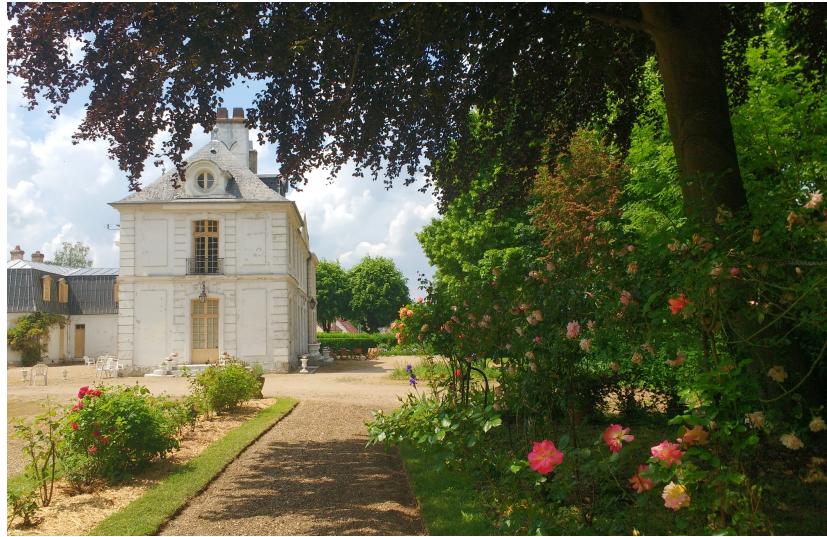
L'axe Est-Ouest de l'ancienne entrée principale
