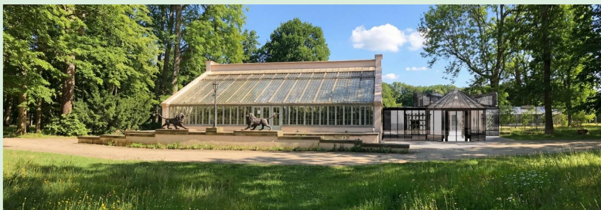
Vermehrungshaus und Blumenpavillon am Eingang zur Schlossgärtnerei Szklarnia do rozmnażania roślin i pawilon kwiatowy
